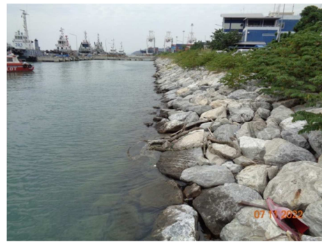
ภาพที่ 2.2-12 แนว REVETMENT บริเวณท่าเรือแหลมฉบัง
